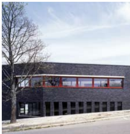
Baden-Württembergs Neueste: Mensa Tiefenbronner Straße Pforzheim
