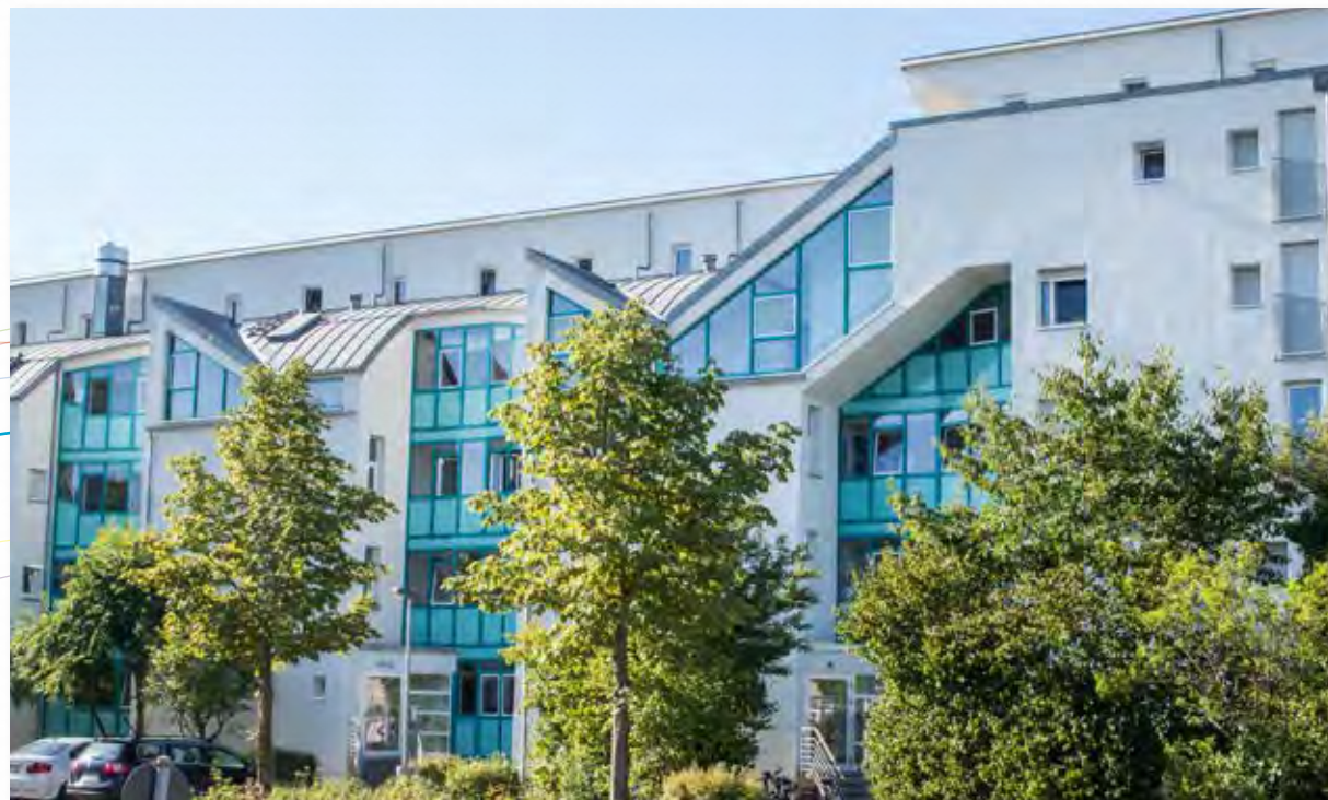
▲ Abb. Das Wohnheim Beuthener Straße 6, Karlsruhe (Waldstadt).
